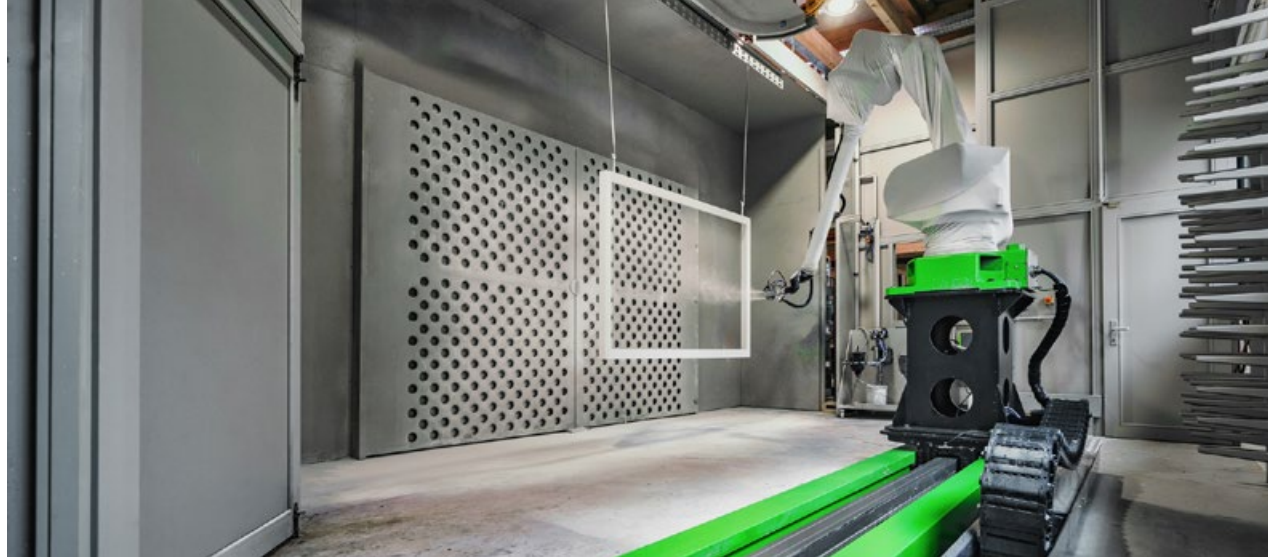
Der Lackierroboter bei der Arbeit in der Spritzkabine. Die Farbwolke, die aus den Düsen kommt, ist deutlich zu sehen.
